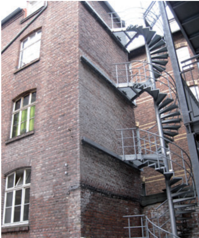
29 Treppe ohne Zugang (Enno Berg)
