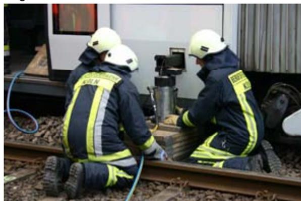
Anheben der Straßenbahn mittels Hydraulikheber
