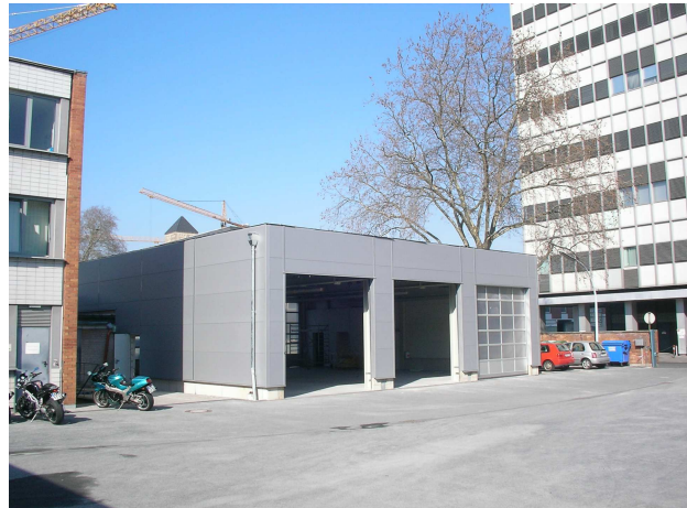
Rohbau FW 1, Foto: Feuerwehr Köln
