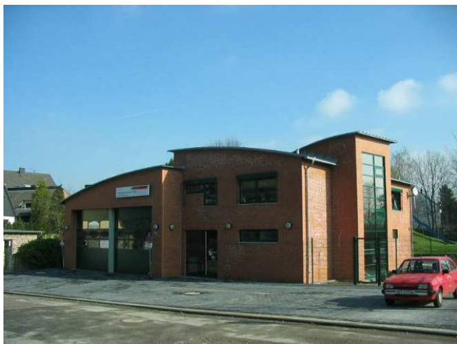
Neues Gerätehaus der Löschgruppe Widdersdorf, Foto: Bildstelle
