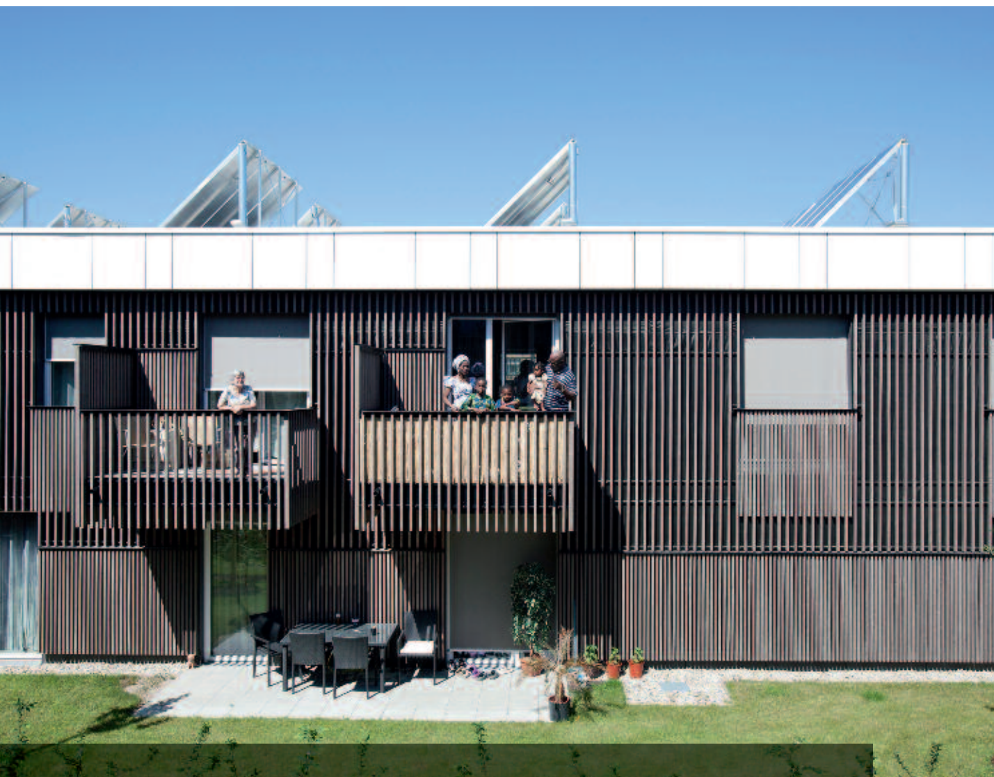
Die Wohnanlage für Familien ist ein Pilotprojekt des öffentlich geförderten Wohnungsbaus. Der sparsame und effiziente Umgang mit Energie zeigt sich vor allem in der Wärmeversorgung. Sie wird vorrangig über Solarkollektoren auf den Dächern gedeckt.
