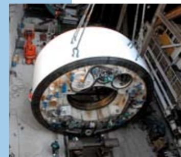
Die Tunnelbohrer werden in Einzelteilen angeliefert, in die Baugrube gehoben und dort zusammengesetzt.
