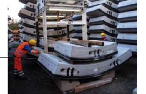
Am Bahngelände Bonntor wurde ein 9.000 Quadratmeter großes Basis- und Nachschublager für Tübbinge eingerichtet.
