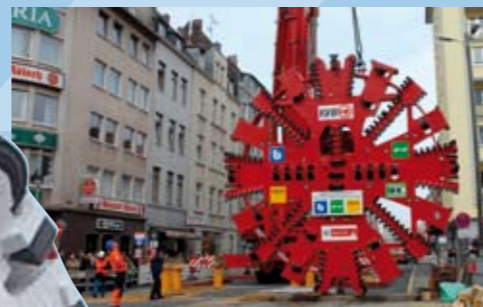
Die Tunnelbohrer werden in Einzelteilen angeliefert, in die Baugrube gehoben und dort zusammengesetzt.
