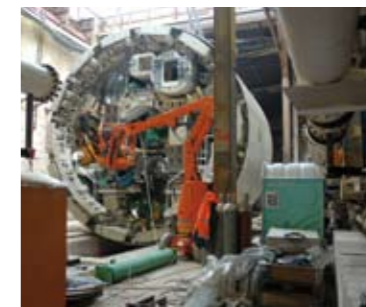
Die Tunnelbohrer werden in Einzelteilen angeliefert, in die Baugrube gehoben und dort zusammengesetzt.
