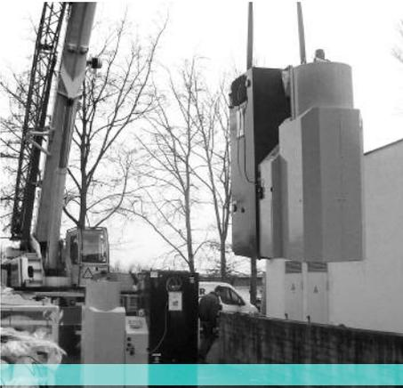
Die drei Pelletkessel werden per Kran in den Keller transportiert ...
