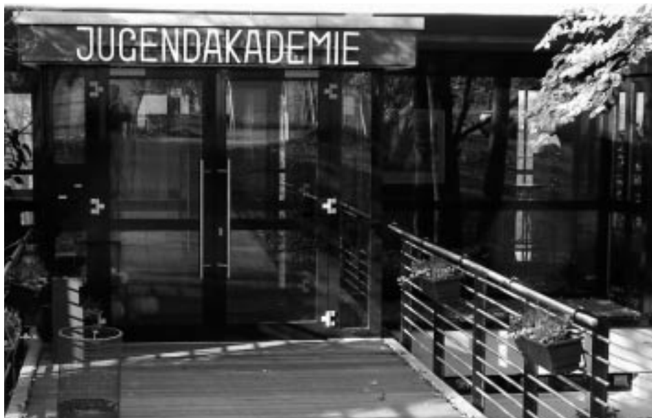
Brücke und Eingangsbereich der Jugendakademie wurden saniert und neu gestaltet.
