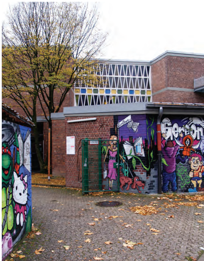
Bestandsgebäude der Grundschule
