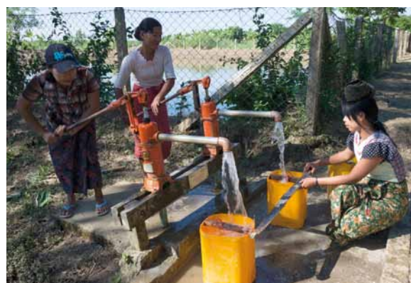
In den beiden Townships haben die Malteser Dorfteiche eingezäunt, Brunnen gebohrt und Regenwassersammeltanks gebaut, um eine ganzjährige Versorgung mit sauberem Trinkwasser sicherzustellen.
