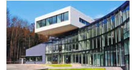
Neugestalteter Eingangsbereich des Standorts Lampoldshausen
