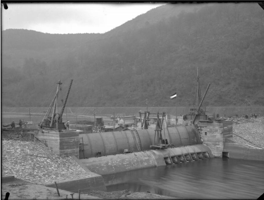
*Die Wehrschwelle ist fertig, die Fischbauchklappen angebracht. Zu sehen sind im rechten Teil der Wehrschwelle die Öffnungen zum Durchfluss der Rur, die bis auf eine, den Notauslass bzw. späteren Grundablass 2, geschlossen wurden. Ebenso zu sehen sind die Zahnstangen der Fischbauchklappen und die sie bewegendes Windwerke.*
