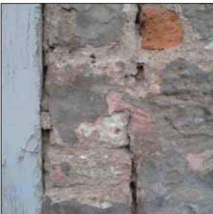
*Fassadendetail Peterstraße 77 vor der Sanierung: Deutlich kann man die verschiedenen Schichten erkennen, mit denen die Ziegelfassade geschlämmt wurde: 1. weiß-gelbliche Farbe, 2. ein Rotton, 3. Zementgrau. Heute ist die Fassade verputzt und der Ziegelstein nicht mehr zu erkennen.*
