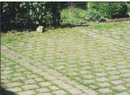
Die speziellen Rasensorten werden durch die Befahrung kurz gehalten. Die Grasnarbe wird dadurch geschützt, dass sie sich ca. 1 cm unterhalb der Steinoberfläche ausbildet. Der Fugenverbund bietet im Gegensatz zu den Raseninseln bei Rasengittersteinen, Kleinstlebewe-
