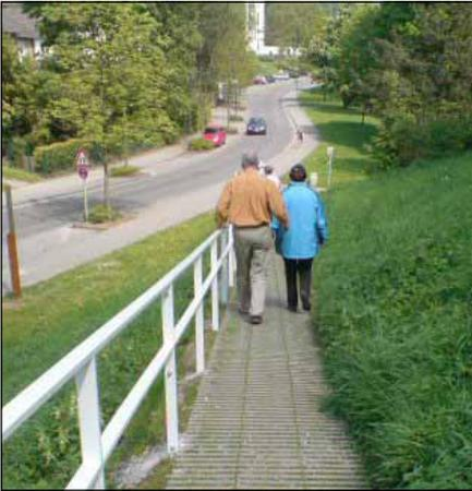
Um sicheren Tritt diese Steigung auf den Wall zu nehmen eignet sich eine Form des Rasenfugenpflasters, wie es jüngst in Aachen an der Station „Höhenweg“ des Weißen Weges Pferdelandpark gebaut wurde. Von oben sehen die Steine wie senkrecht stehende Gehwegplatten (30x4x12) aus, die im Abstand von 4 cm versetzt wurden.
