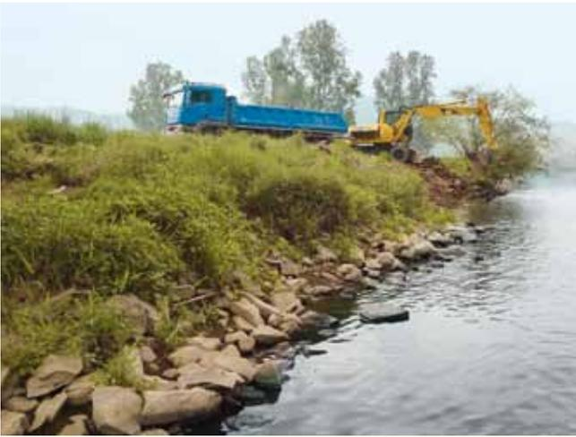
Durch die Entnahme der Wasserbausteine wird der Fluss von seinem Korsett befreit. Die Arbeiten sind nur mit geringem Aufwand verbunden und können innerhalb kurzer Zeit durchgeführt werden.
