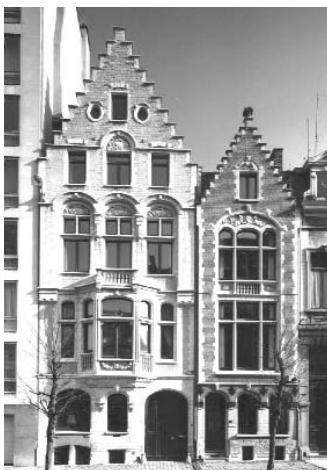
...und hier typisch niederländische Giebelhäuser.
