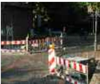
Derzeit laufen die Bauarbeiten zur Erstellung eines behindertengerechten Zuganges zum Neubaugebäude des Rathauses Niederzier. Zur Führung der beeinträchtigten Rathausbesucher werden taktile Elemente in die neue plangleiche Pflasterfläche integriert.
