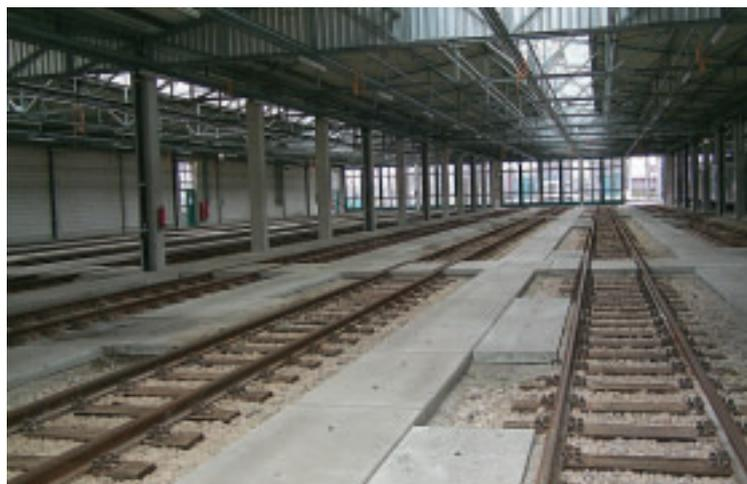
Sinnvolle Stützweiten mit einem Dachtragwerk aus Stahlfachwerkbindern versprechen eine wirtschaftliche Gebäudekonstruktion und lassen eine spätere Umnutzung zu
