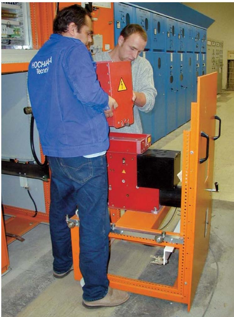
Instandhaltungsarbeiten in einem Unterwerk der Hamburger Hochbahn AG: Abbau der Funkenkammer eines Gleichstrom-Schnellschalters
