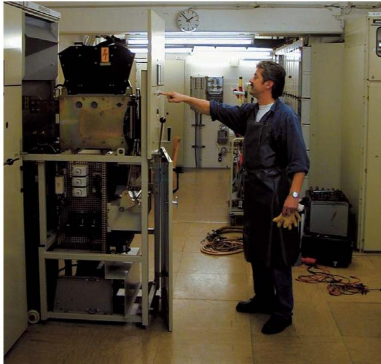
Instandhaltungsarbeiten in einem Unterwerk der Hamburger Hochbahn AG: Herausziehen des Schaltwagens eines Streckenschalter-Feldes
