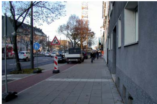
Eine typische Baustelle an der Aachener Straße
