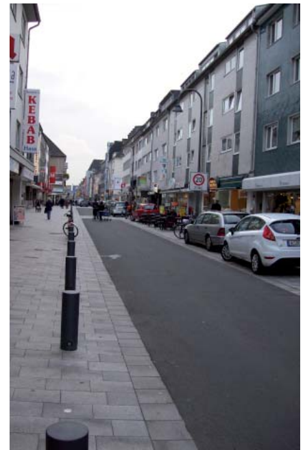
Neu gestaltete Severinstraße: breitere Bürgersteige, keine beidseitigen Parkplätze, für den Radverkehr geöffnet
