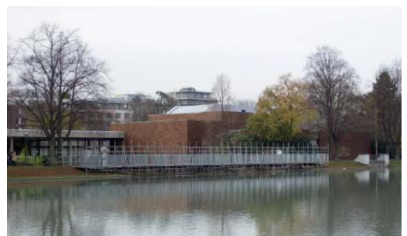
Die Behelfsbrücke stört nicht nur den Blick auf das Museum, sondern unterbricht auch den Radweg durch den inneren Grüngürtel.
