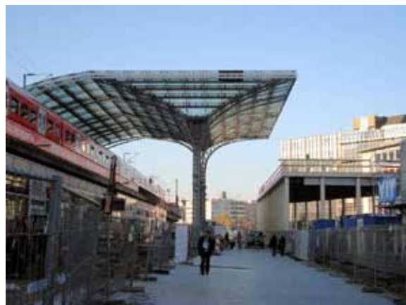
Ab Dezember ist es möglich: auf kurzem Weg und trockenen Fußes von der S- direkt zur U-Bahn
