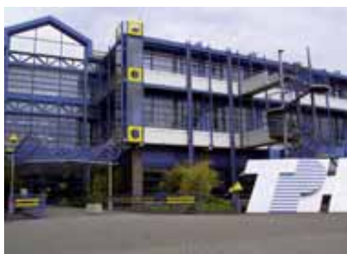
Technologie Park Herzogenrath
