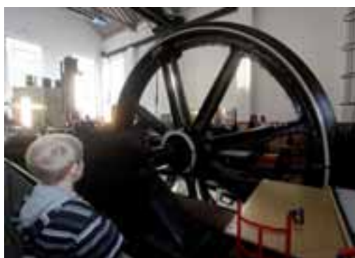
Alte Fördermaschine in Merkstein
