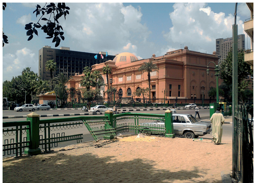
Abb. 4 Unmittelbar hinter dem Ägyptischen Museum ist das ausgebrannte Parteigebäude der ehemals regierenden NDP (Nationaldemokratische Partei), dessen Präsident Hosni Mubarak war, zu erkennen. Im Vordergrund ein durch die Demonstrationen zerstörtes Straßengeländer auf dem Tahir-Platz. (Foto: Karin Kindermann)
