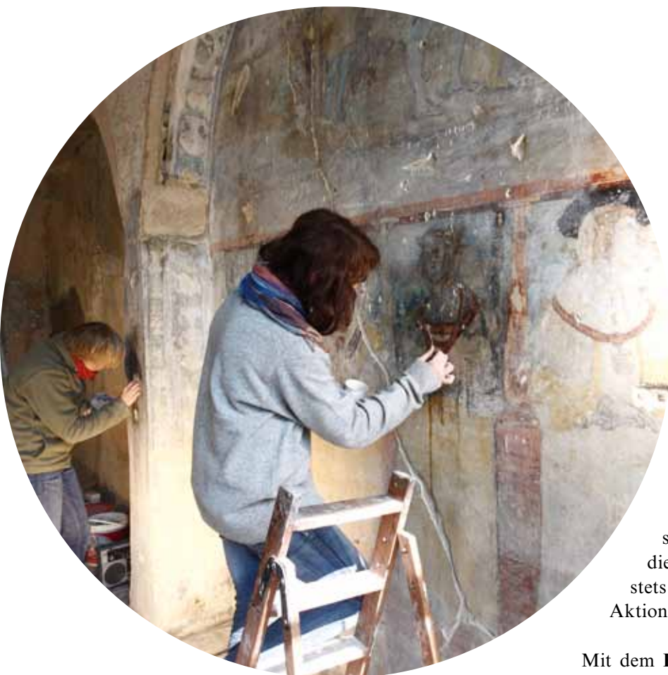
Spenden ermöglichten Restaurierungsarbeiten in Görlitz.
