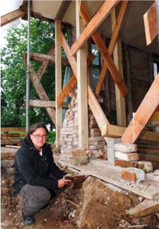
Das Fundament aus Feldstein war aufgeweicht und abgesackt. Die ganze Kirche hatte sich verformt. Heute ist das Fachwerk restauriert, das Dach gedeckt und die Kirche steht wieder auf sicherem Grund.
