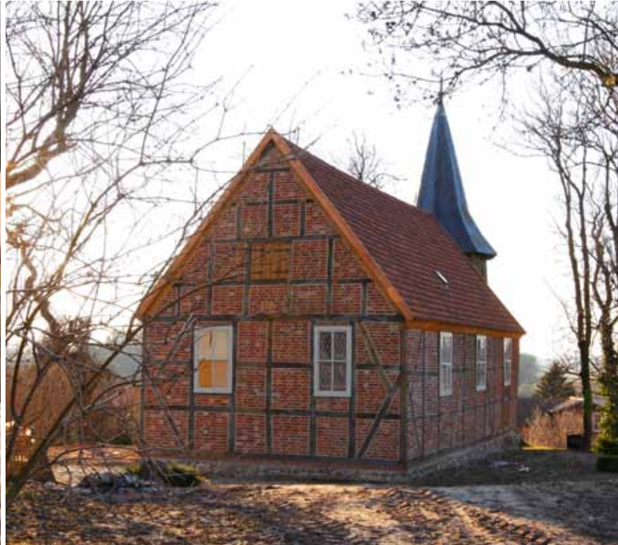
Das Fundament aus Feldstein war aufgeweicht und abgesackt. Die ganze Kirche hatte sich verformt. Heute ist das Fachwerk restauriert, das Dach gedeckt und die Kirche steht wieder auf sicherem Grund.
