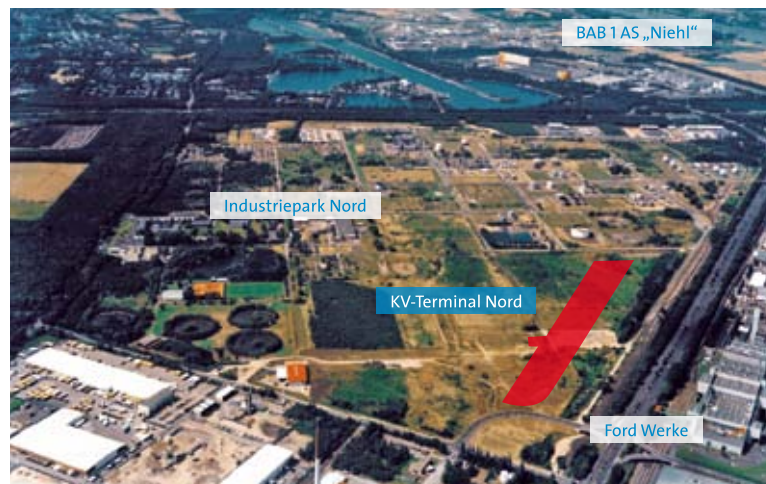
KLV-TERMINAL KÖLN NORD
