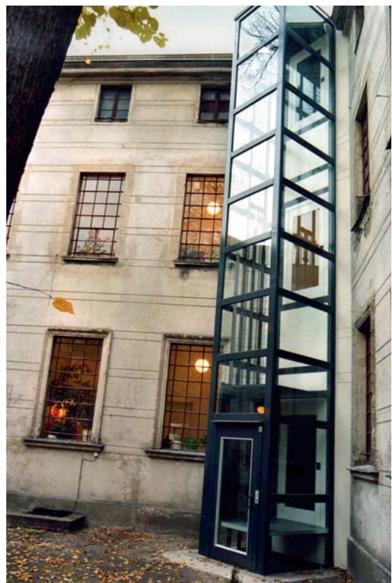
Dank des neuen Aufzugs erreichen auch gehbehinderte aidsranke Menschen die oberen Etagen des neuen Hauses
