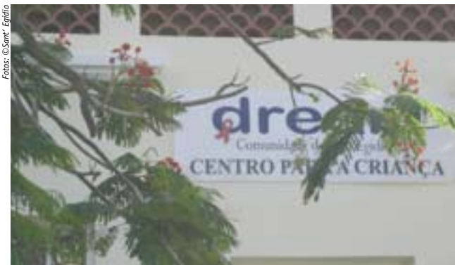
Die neue Gesundheitsstation in Maputo-Zentrum.
