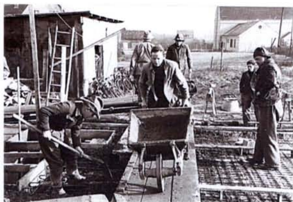
Peter mit Schubkarre beim Gießen der Kellerdecke im Jahre 1954; Betonverteiler war Oskar Hüniger Kritischen Blickes mit Motorradhaube: de Halfens Düres (Theo Halfen).
