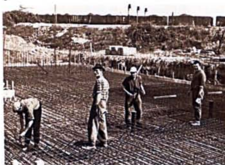
Baubeginn im April 1967
