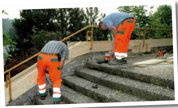
Ausbesserungsarbeiten an einem Treppengeländer.
