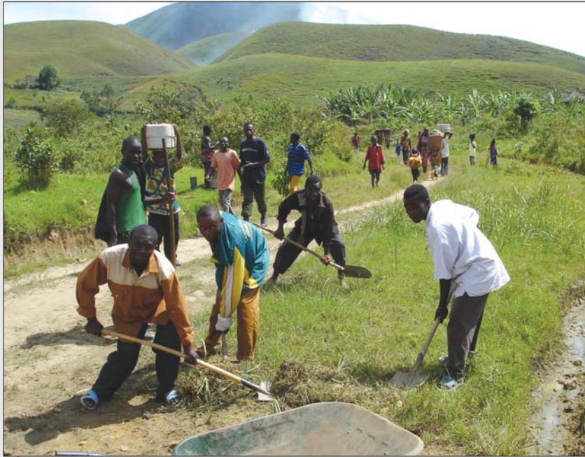
Stück für Stück stellen die Mitarbeiter der Malteser diese Straße in der Region Süd-Kivu wieder her
