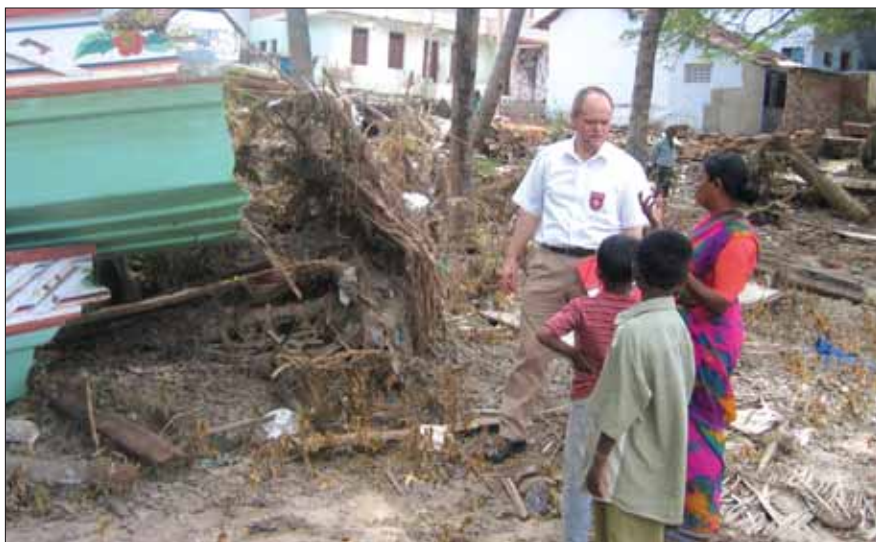
Nur Trümmer sind übrig geblieben: Eine Frau schildert dem Malteser Martin Pfeifer in einem Dorf im indischen Kanyakumari-Distrikt die Zerstörung durch die Flutwelle
