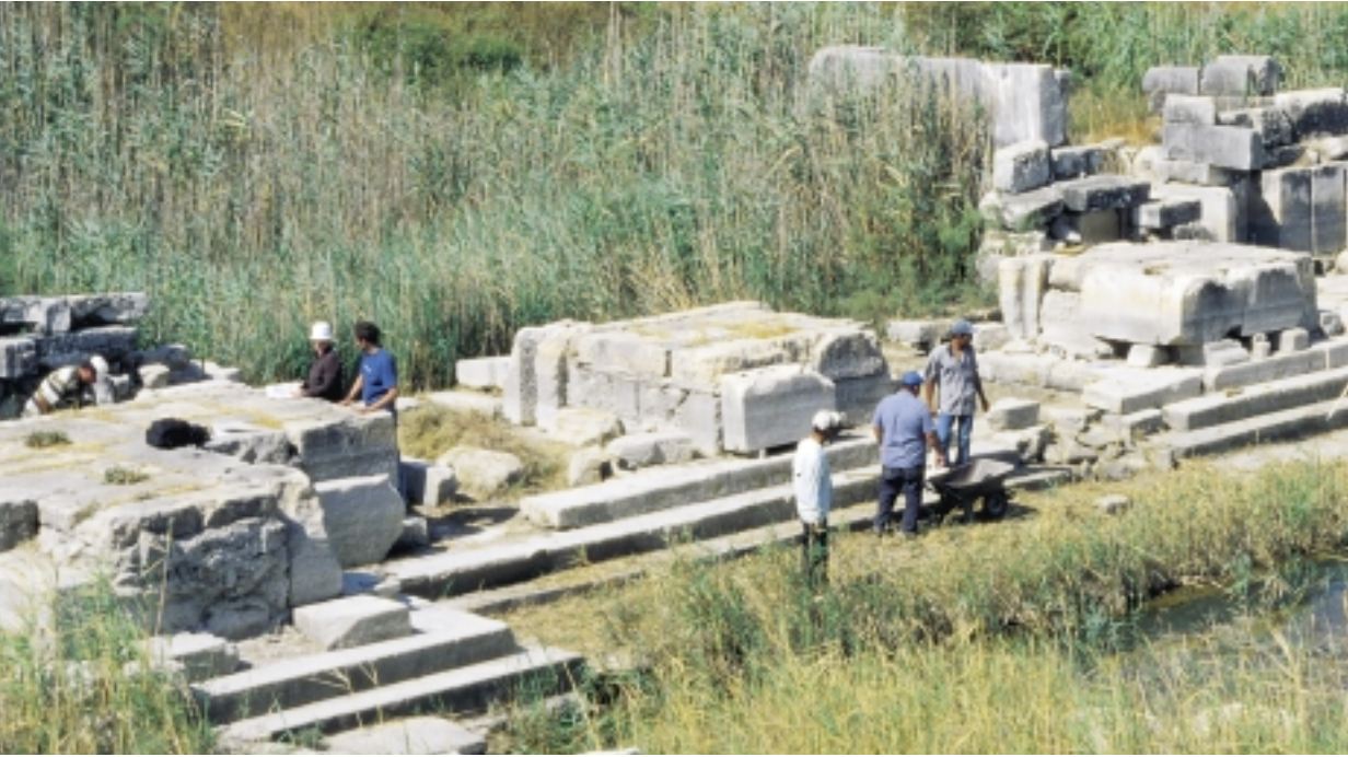
Projekt „Markttor von Milet“: Der originale Sockel des römischen Markttors in Milet. Das Foto zeigt die Reinigung und Vermessung des antiken Bauwerks während der Kampagne im Sommer 2004.
