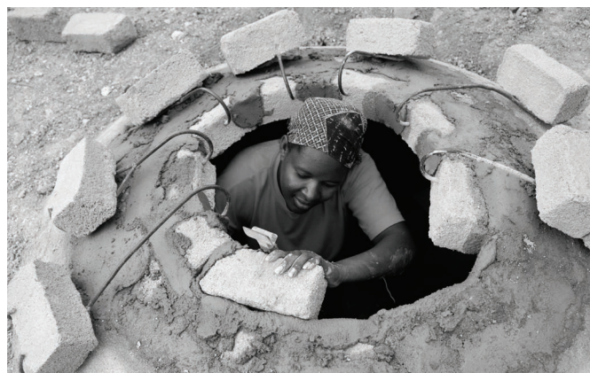
Tansania: Der Bau von Biogasanlagen ist in der Region um Dodoma/Tansania eine der Maßnahmen, um den Raubbau an der Natur zu stoppen.
