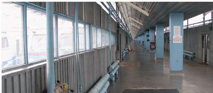
▲ Bahnhof in Tschernobyl. Der Bahnsteig ist zur Zugseite geschlossen und verfügt über Türöffnungen, deren Positionen mit den Waggontüren übereinstimmen. Dadurch werden Kontaminationen im Bahnhof- und Zuginneren vermieden.
