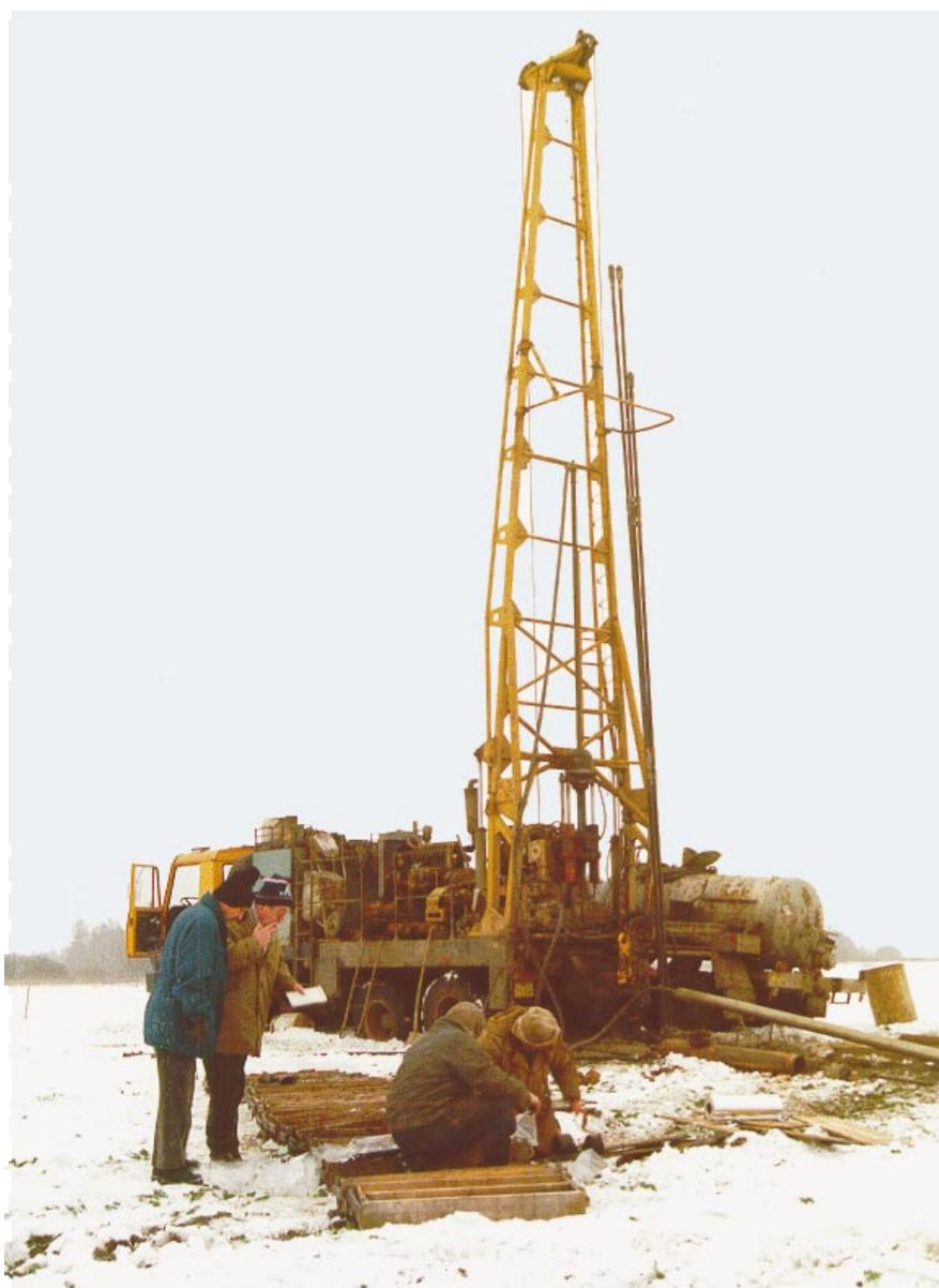
Zur Überprüfung der Standortverhältnisse wurden in der Umgebung von Ruprechtov Aufschlußbohrungen bis ca. 40 m abgeteuft
