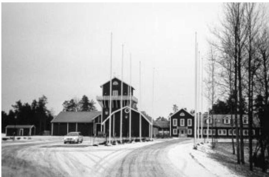
Bürokomplex über dem Hartgesteinslabor ÄSPÖ in Schweden. In der Bildmitte ist das turmförmige Schachtgebäude mit dem Fahrstuhl nach unter Tage bis ca. 500 m unter Geländeunterkante zu erkennen
