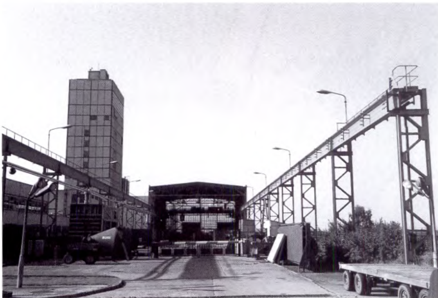
Bild 3.7: Förderturm und Umladehalle
