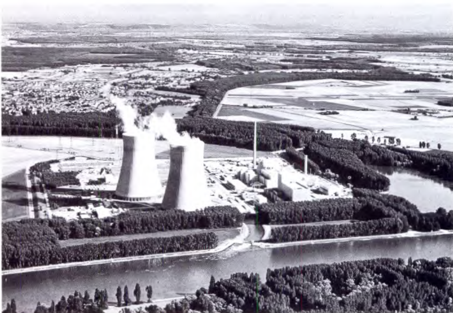
Bild 3.4: Kernkraftwerk Philippsburg mit DWR und SWR (Luftbild Brugger GmbH, Stuttgart Nr. 2/63017 C)
