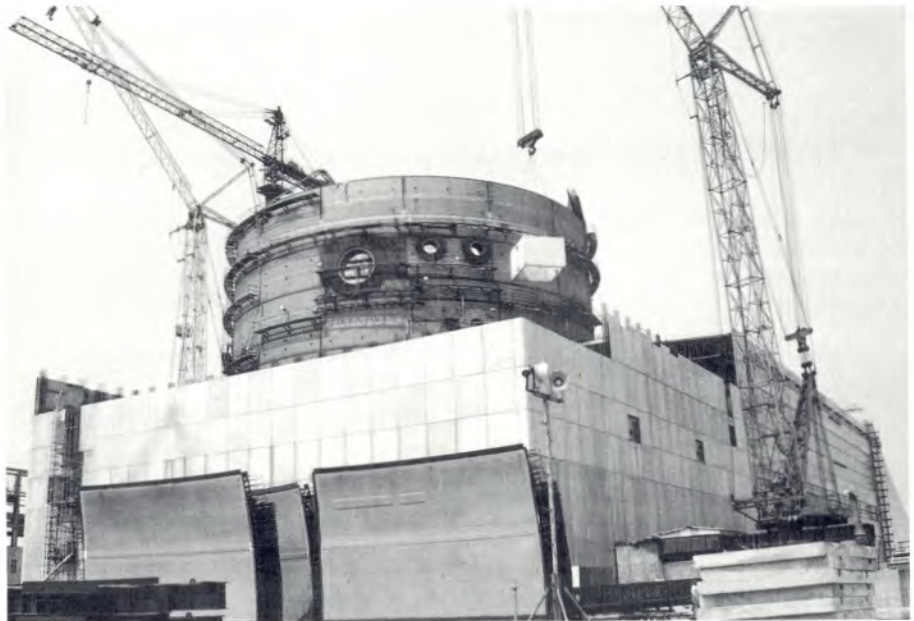
Bild 2.2: Das Reaktorgebäude für Block 1 des DDR-Kernkraftwerks Stendal
