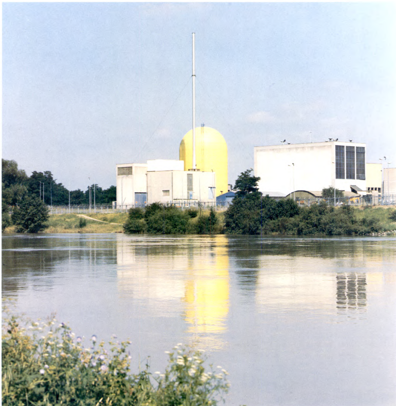
4 Das Versuchsatomkraftwerk Kahl, der erste Leistungsreaktor in der Bundesrepublik Deutschland, wurde nach 25jährigem Betrieb im November 1985 stillgelegt. (Foto: VAK)
