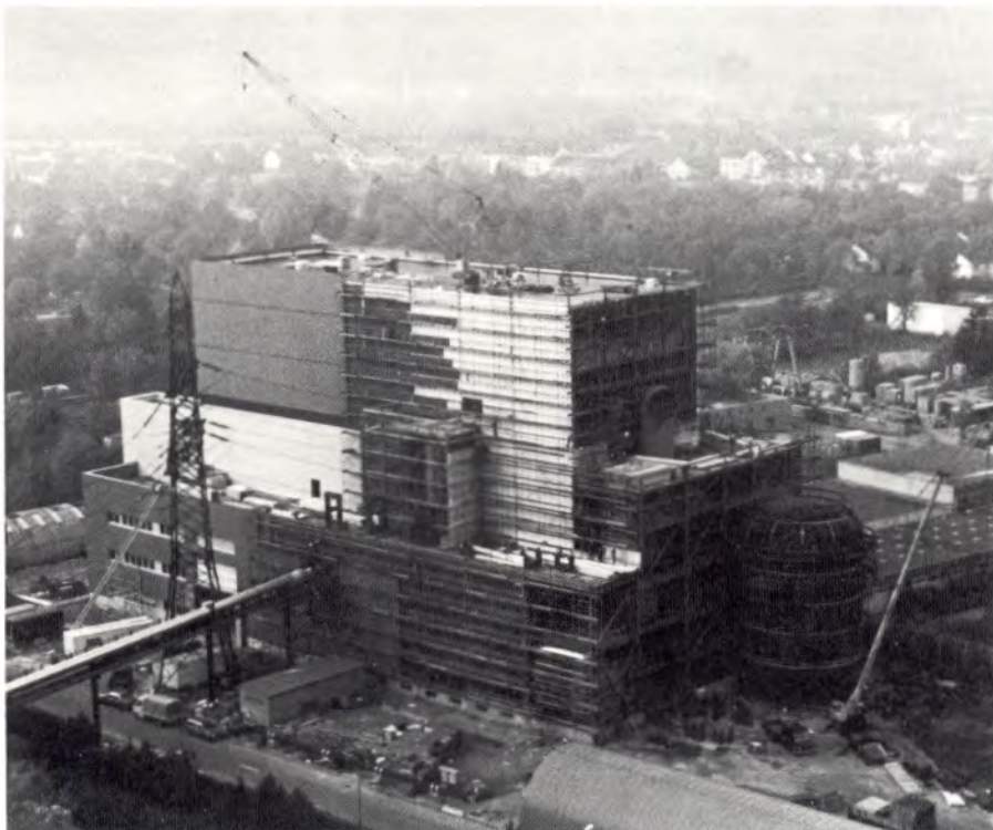
Bild 10.1: Bauzustand des Gebäudes für die „Upper Plenum Test Facility“ im Dezember 1983 auf dem Gelände der Großkraftwerk Mannheim AG. Im Vordergrund links die Dampfversorgungsleitung (ca. 300 t/h). Angrenzend an das Versuchsgebäude der Behälter des Containmentsimulators (Durchmesser 12 m). (Foto: KWU)
