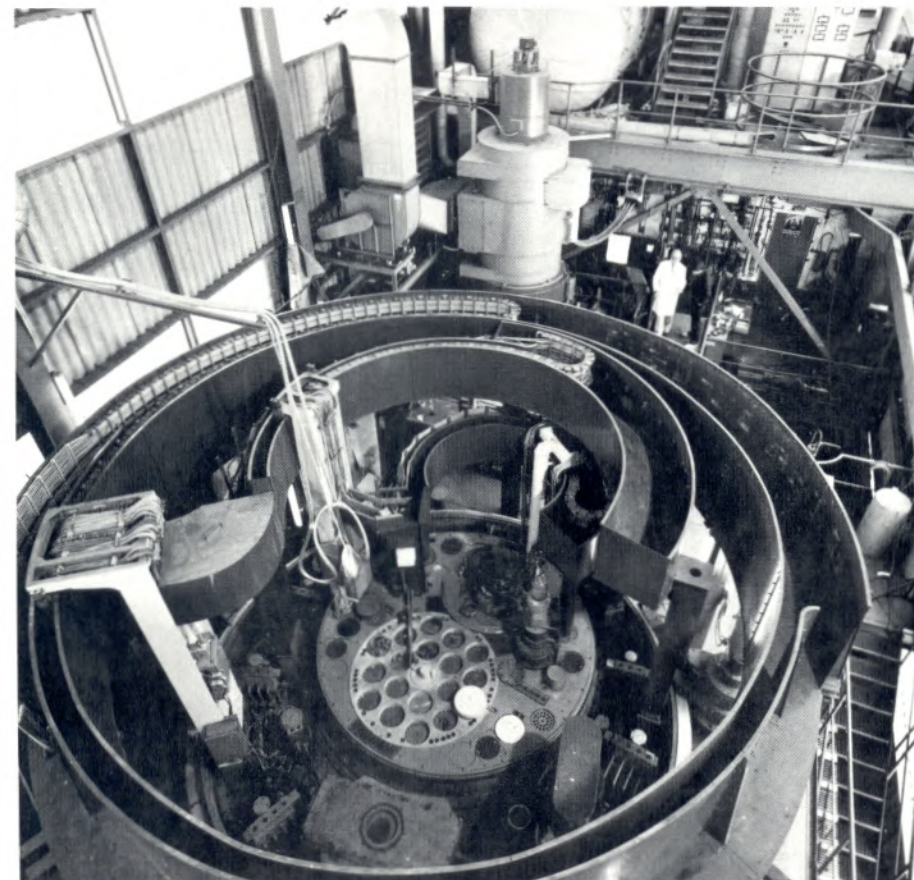
Drehdeckel und Natriumpumpe (KWU-Photo)
