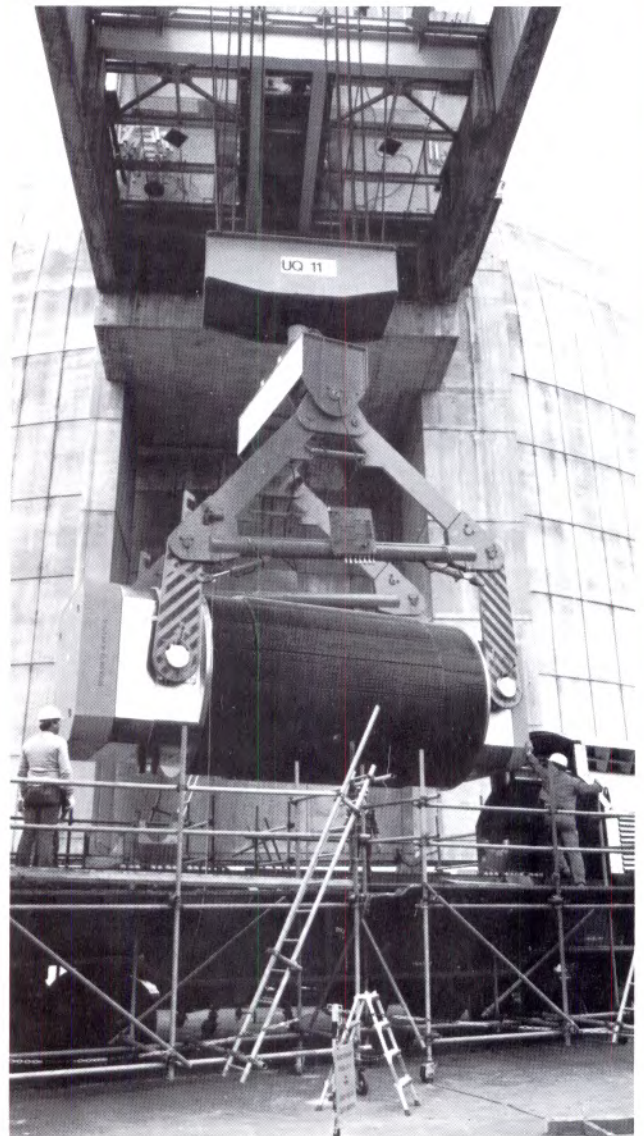
Kernkraftwerk Biblis, Block A: Transportbehälter für verbrauchte Brennelemente (RWE-Photo)
