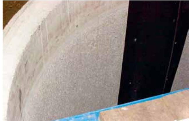
Abb. 2: Betonkorrosion im unbehandelten Referenzreaktor
