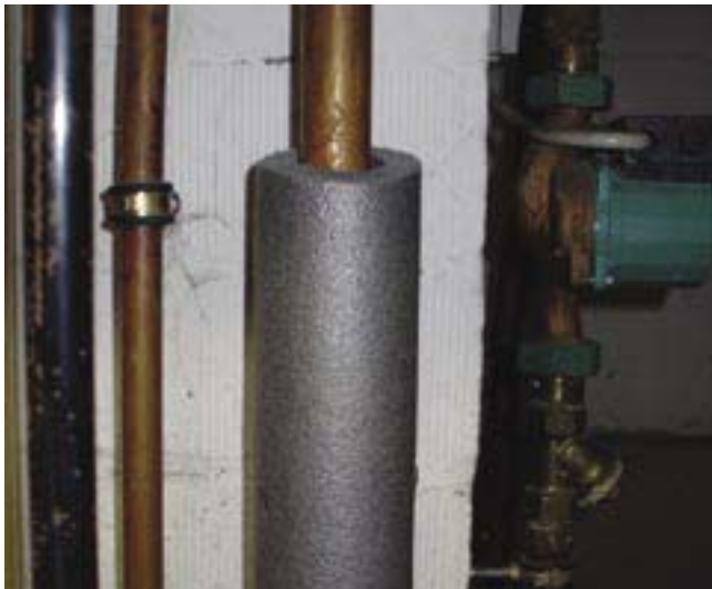
Gedämmte Heizungsleitungen
