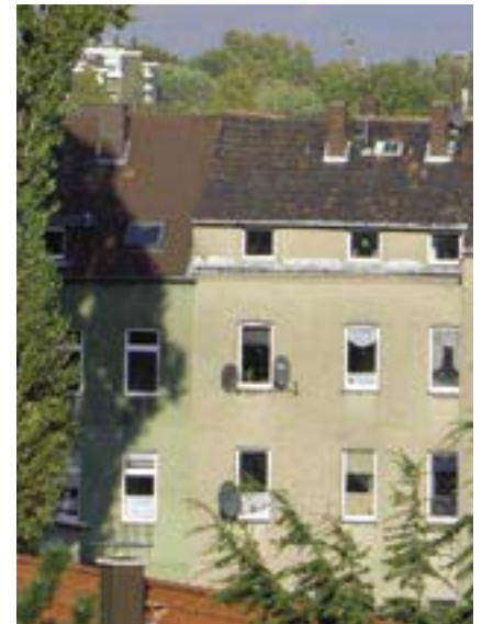
Altes geneigtes Dach
