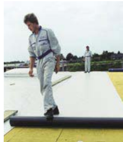
Flachdach – Einbau Dämmung
