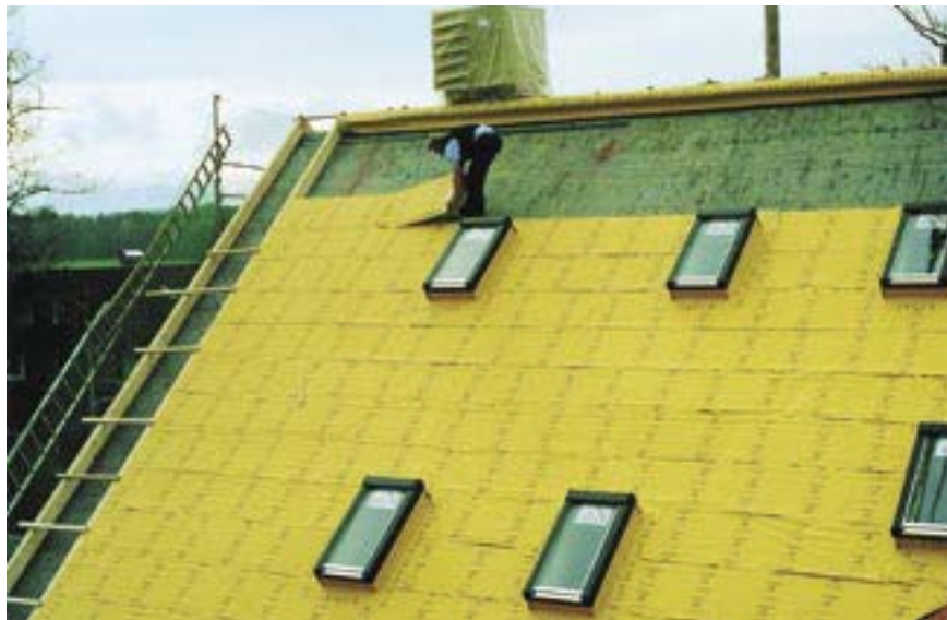
Geneigtes Dach – Einbau Dämmung
