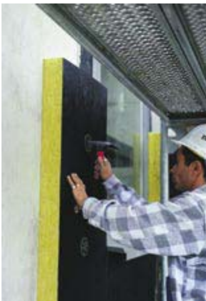
Wärmedämmverbundsystem
