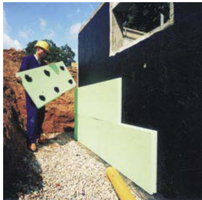
Kellerwanddämmung
