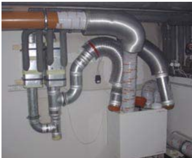
Zentrale Lüftungsanlage
