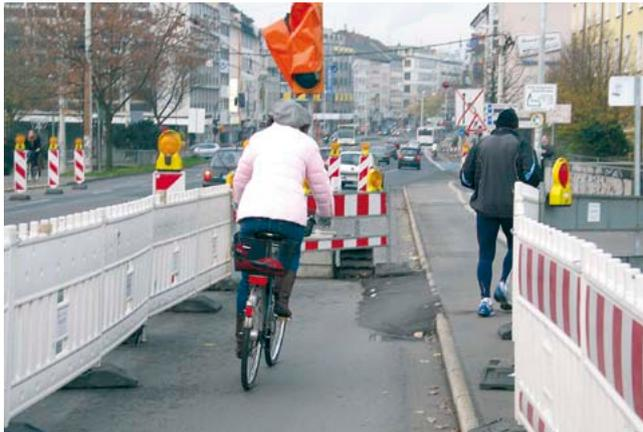
Baustelle mit Sicherung durch Absperrschranken und Bitumenkeil am Übergang zur Baustelle
