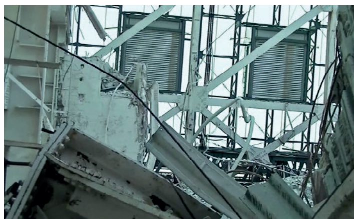
Abb. 6.16: Blick durch den Bedienflur (Quelle: TEPCO).
