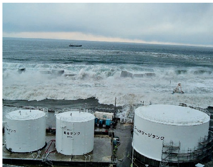
Abb. 3.3: Beginn der Überflutung des Anlagengeländes, aufgenommen von einer Überwachungskamera. Aus späteren Luft- und Satellitenaufnahmen wurde ersichtlich, dass einige Tanks (in diesem Fall zwei Dieselvorratstanks und ein Kühlwasserbehälter) von der Art der hier gezeigten durch den Tsunami zerstört bzw. von ihrem ursprünglichen Standort weggerissen und landeinwärts getragen wurden (Quelle: TEPCO).
