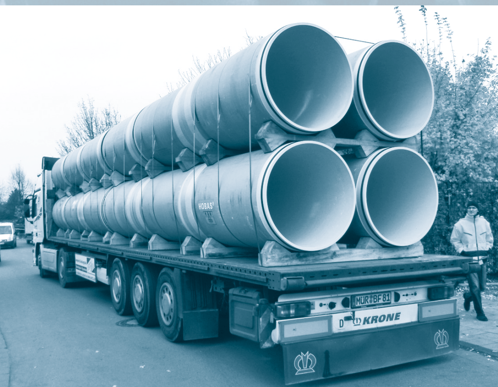
Anlieferung der Berstliningrohre
