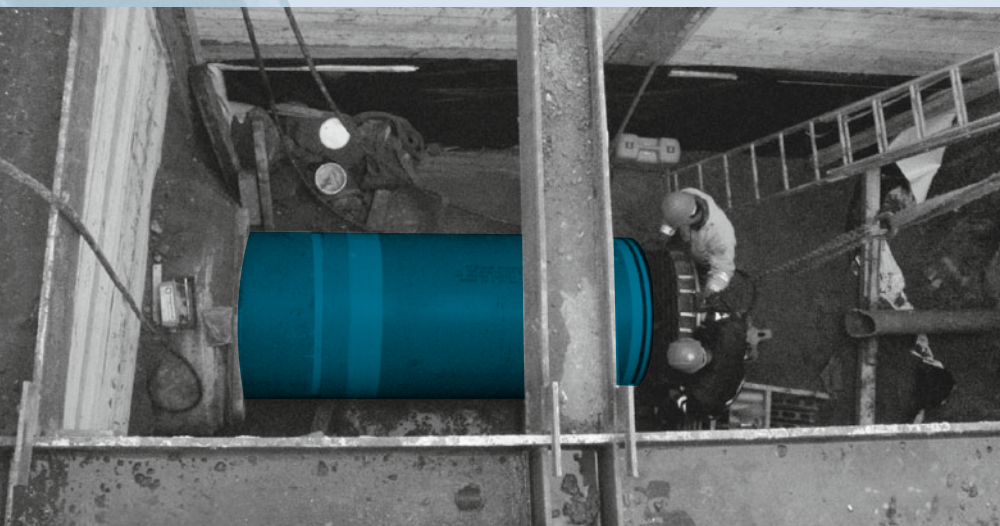
Schachtgruben mit Berstliningrohren
