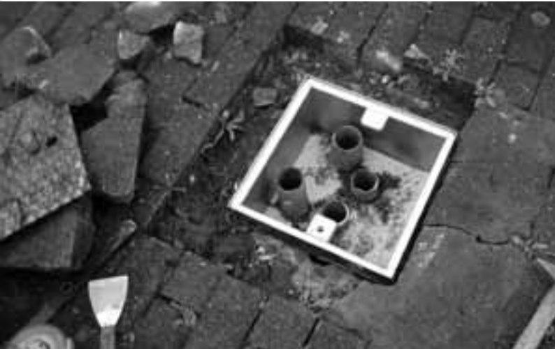
Erneuerung eines Schutzschachtes auf einer Pflasterfläche
