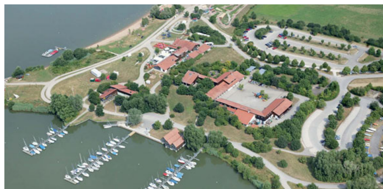
Beispiel der Bündelung von Infrastruktureinrichtungen in Seezentren (Altmühlsee, 2006; Wasserwirtschaftsamt Ansbach)
