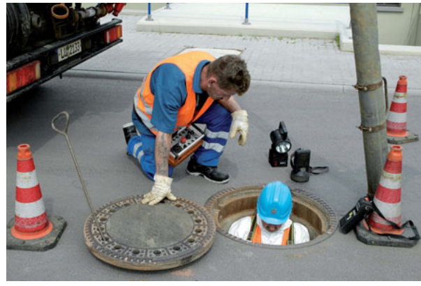
Letzte Absprache vor dem Einstieg in den Schacht. Foto: Matthias Barjenbruch
