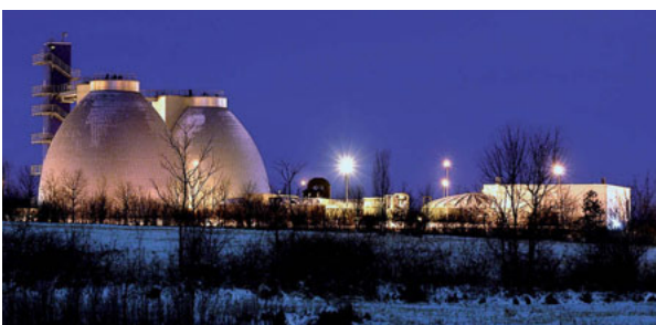
Faulbehälter Halle-Nord – Winterbetrieb. Foto: Matthias Barjenbruch
