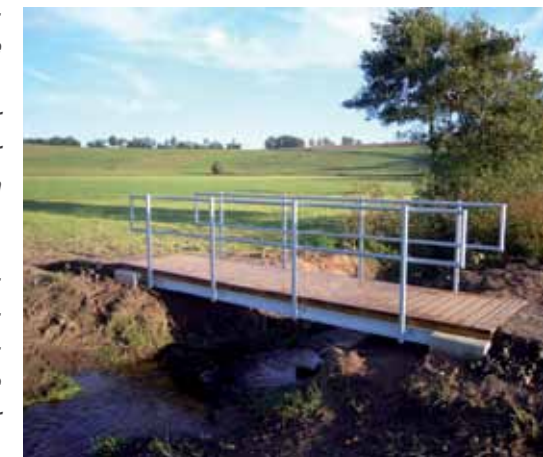
Brücke über den Oosbach nach Fertigstellung.
