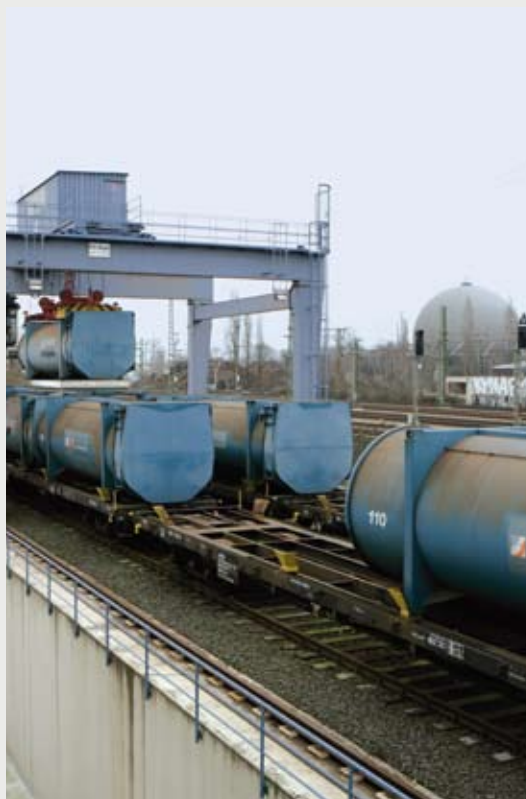
Das Heizkraftwerk Niehl II und die Müllumladestation in Ehrenfeld; mit moderner und innovativer Technik und Logistik für den Standort Köln.
