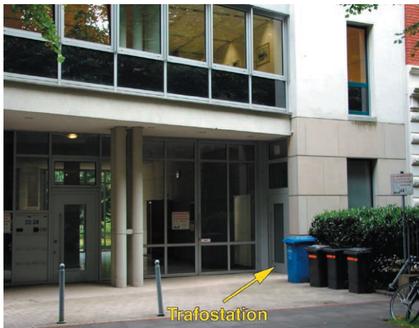
Trafostation architektonisch in die Fassade integriert
