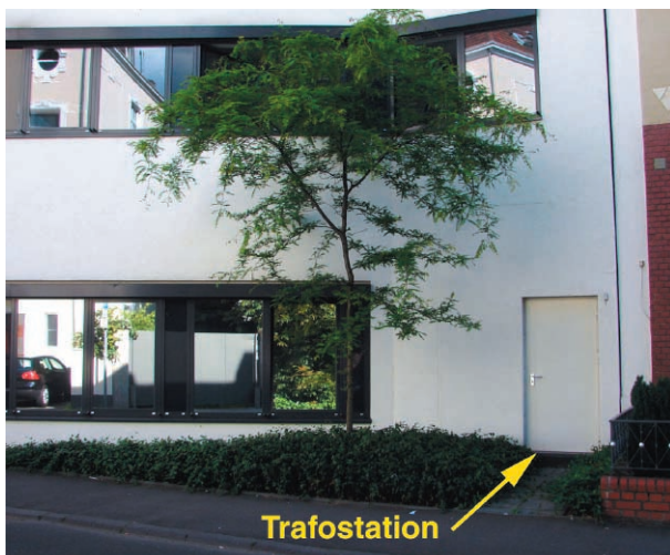
Trafostation hinter neutraler Stahltür
